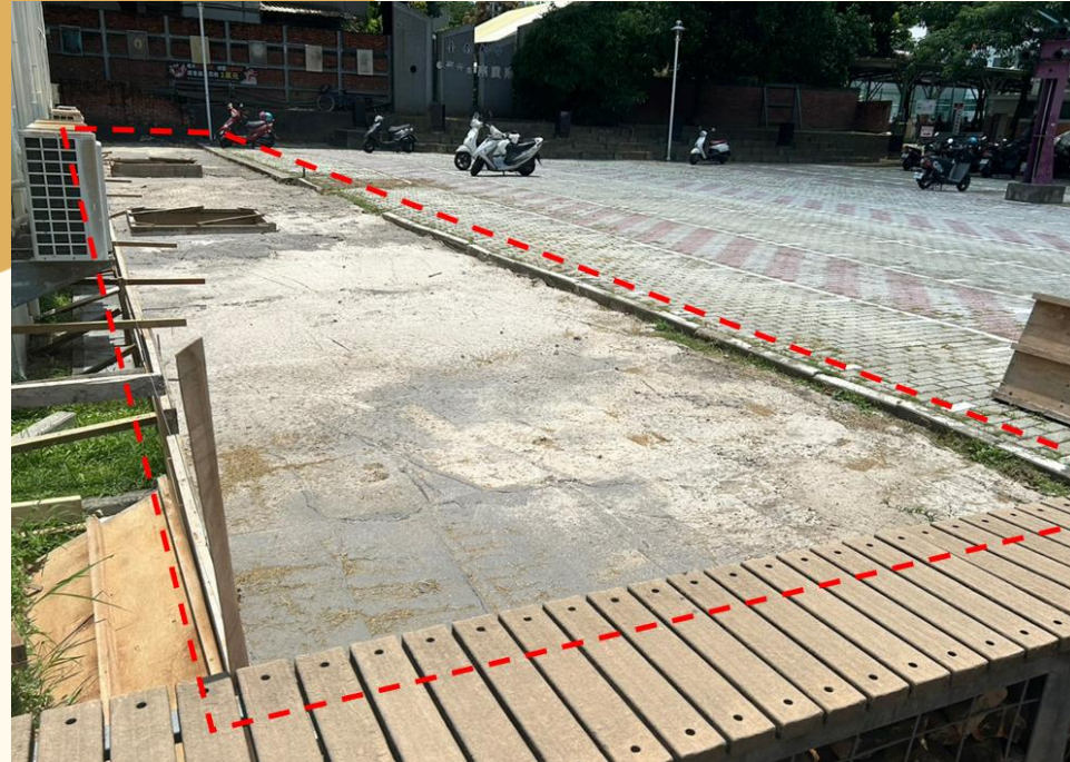
南風停車地坪增建(近完工)-營繕協助
