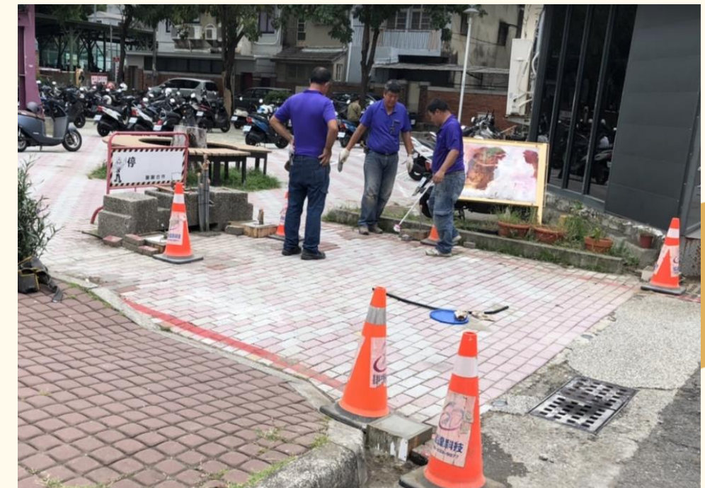
南風停車場-車牌辨識建置
