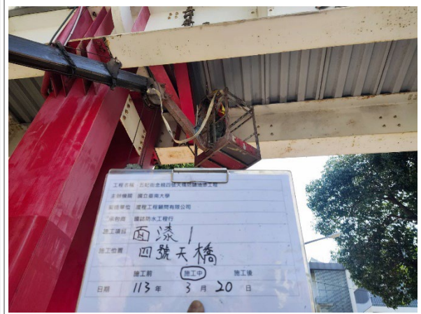
2. 天橋防鏽油漆施工中
