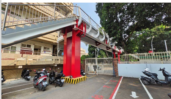
1. 天橋防鏽油漆完工
