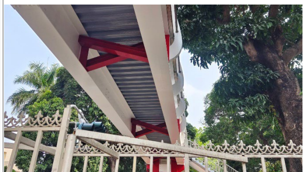
2. 天橋防鏽油漆完工
