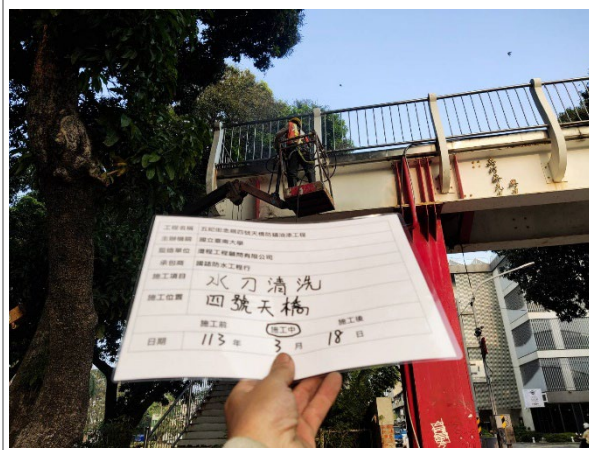
1. 天橋防鏽油漆施工中
