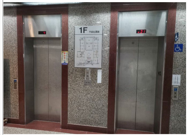
2. 文薈樓 2 部電梯更新前
