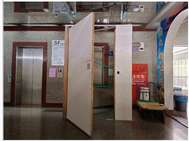
2. 文薈樓 2 部電梯更新中
