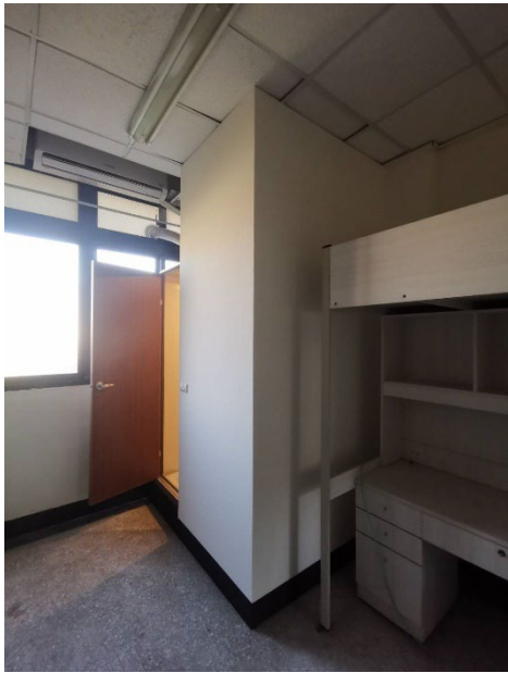
1. 衛浴空間完工
