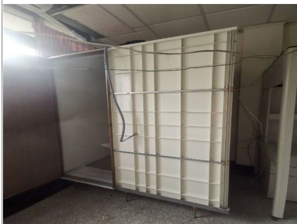
1. 衛浴空間施工中
