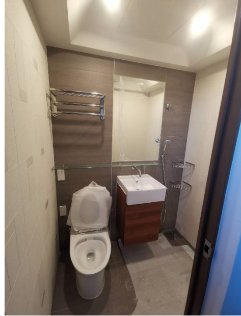
2. 衛浴空間完工
