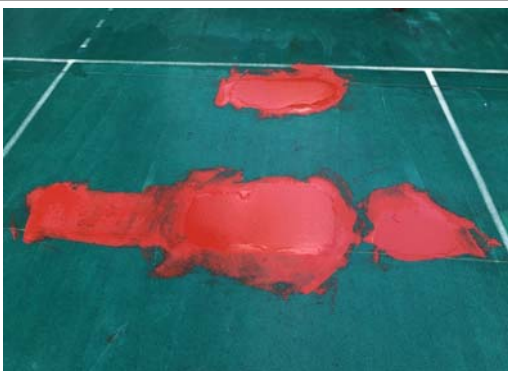
7. 排球場表面坑洞修補
