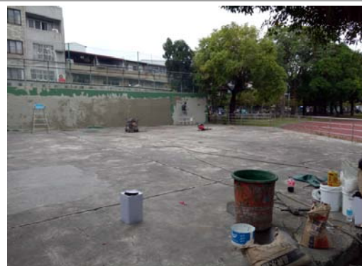
6. 網球場鋪設 PU
