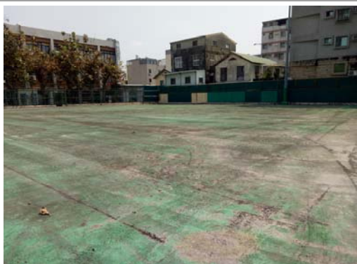
5. 網球場鋪設 AC 及試水
