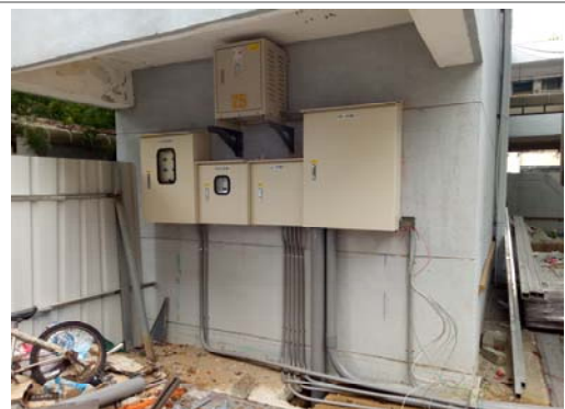
8. 變壓器及配電盤安裝
