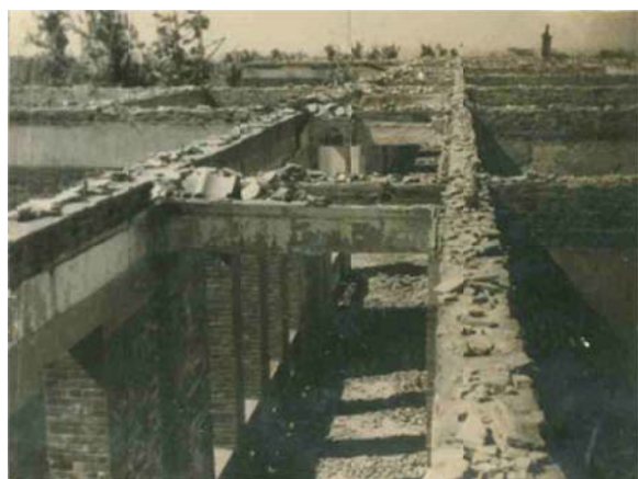
紅樓屋頂毀損之二【摘錄南大校史室】
