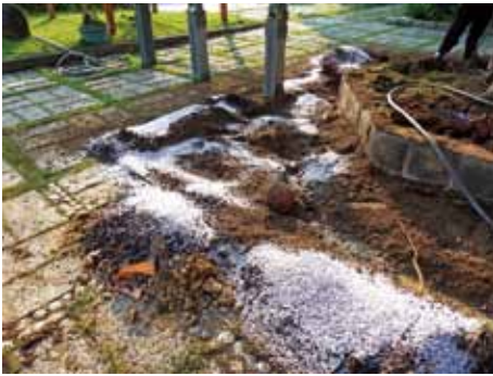
使用酸素管、黑曜石發泡粒、泥炭土、有機肥為硬實排水不良的棲地做物理性的改良。
