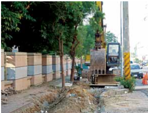
左圖是大型水管理設工程，因重機出入需求，所以修剪了許多大型樹枝，也傷害了樹木。
