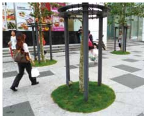
這種支架較貴，且施工常以水泥當基座，過小樹穴又需分給基座。
