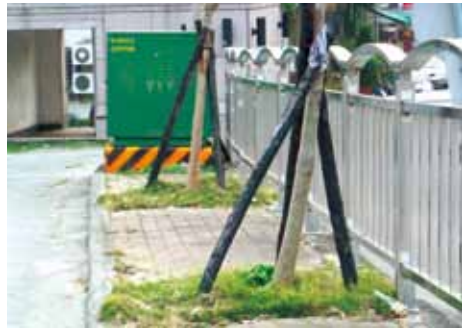
三木支架承受風力約30m/sec。此價格便宜，但人工地盤並不適用。
