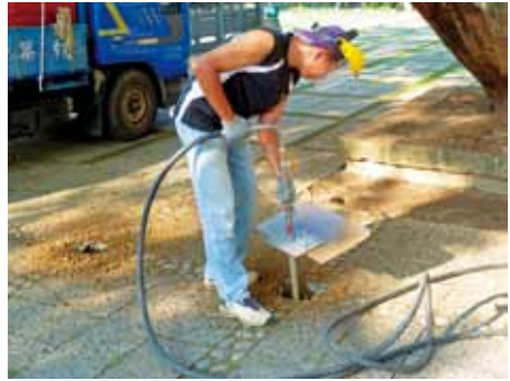
採用保根挖掘系統改良土壤。
