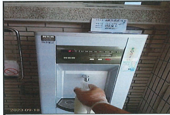
日期 : 112.09.18 地點 : 雅音樓3F 內容 : 監測情形
