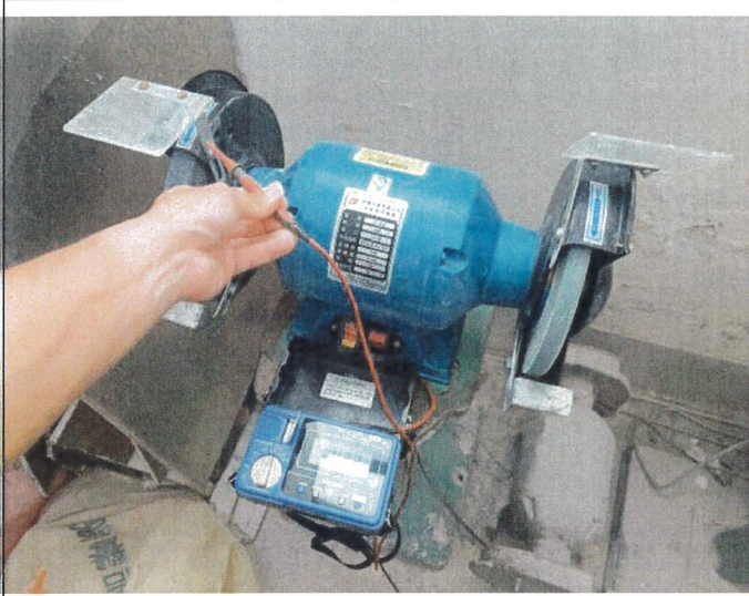
絕緣電阻值量測
